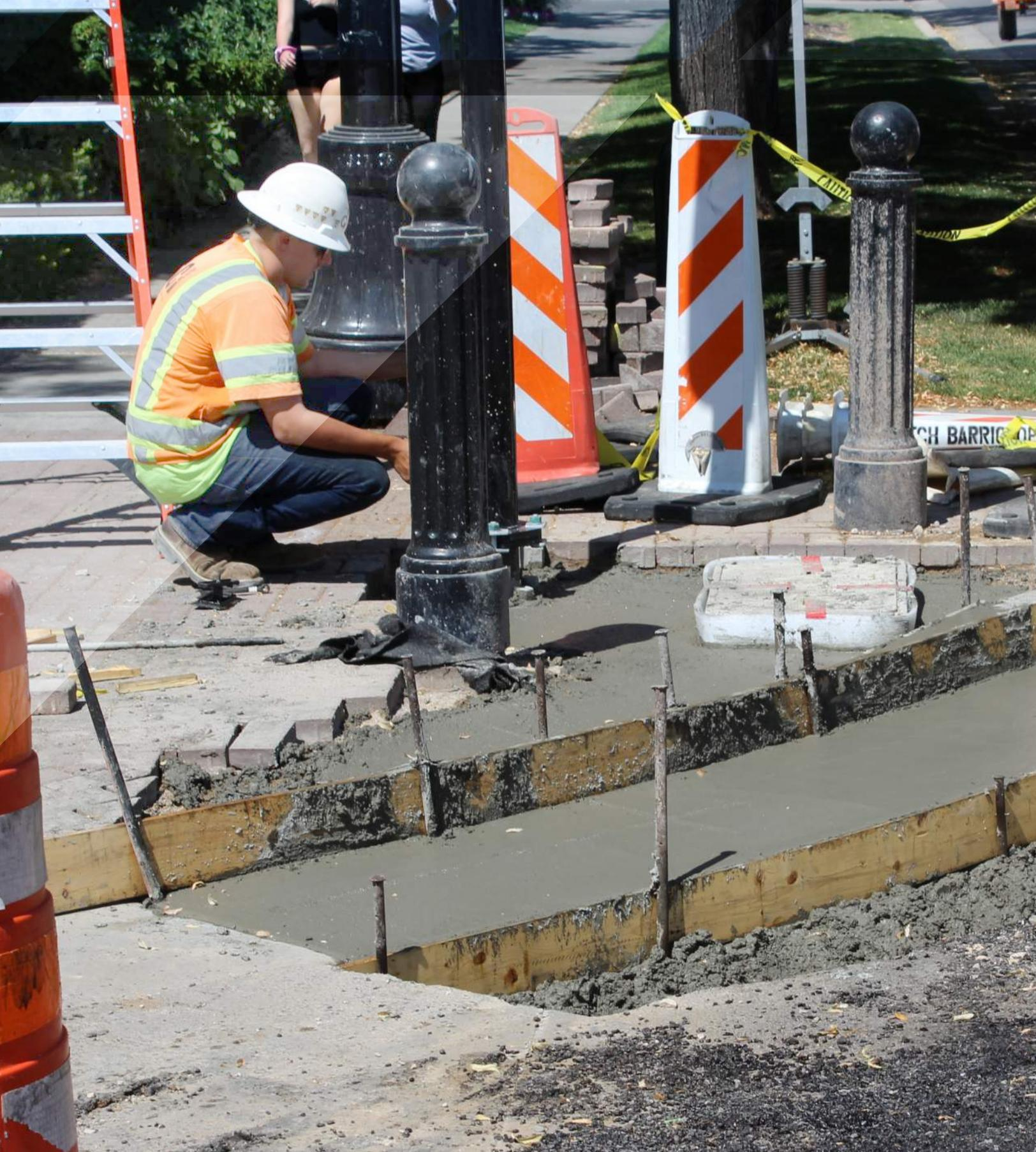
*Los proyectos de construcción de carreteras a menudo incluyen la mejora o sustitución de la cuneta, que reduce el encharcamiento y mejora la corriente de aguas pluviales para las propiedades vecinas.*
