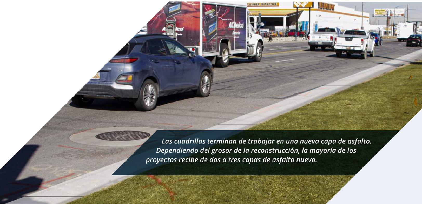
*Las cuadrillas terminan de trabajar en una nueva capa de asfalto. Dependiendo del grosor de la reconstrucción, la mayoría de los proyectos recibe de dos a tres capas de asfalto nuevo.*
