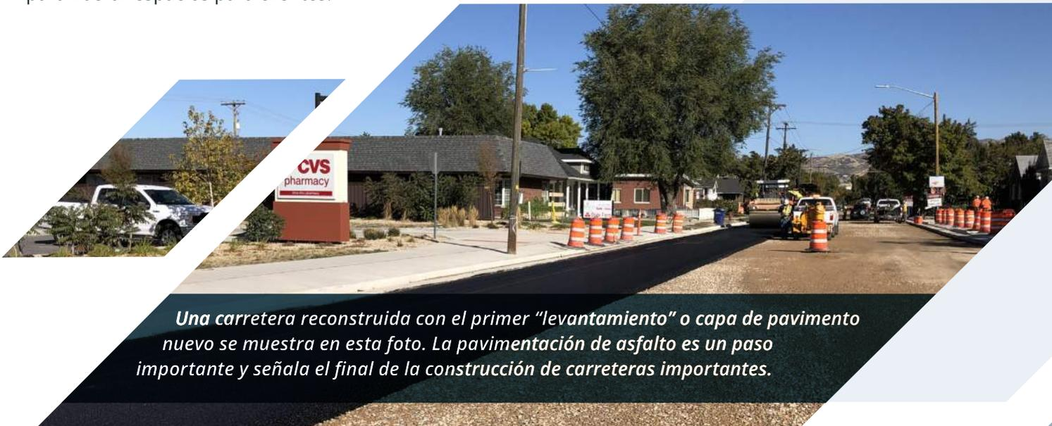
*Una carretera reconstruida con el primer "levantamiento" o capa de pavimento nuevo se muestra en esta foto. La pavimentación de asfalto es un paso importante y señala el final de la construcción de carreteras importantes.*
